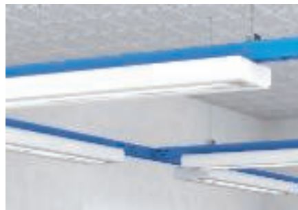
Применение кабельных лотков для монтажа светильников
