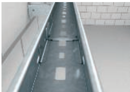
Продольное соединение кабельных лотков для монтажа светильников
