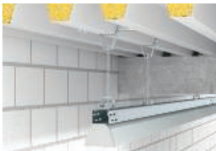
Подвес к трапециевидным балкам
